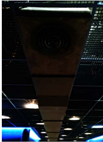
Imagen 6. Conducto de aire de climatización zona exposición
