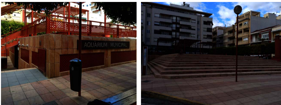
Imagen 2. Fachada de fábrica revestida de chapado de piedra - Cubierta plana transitable
