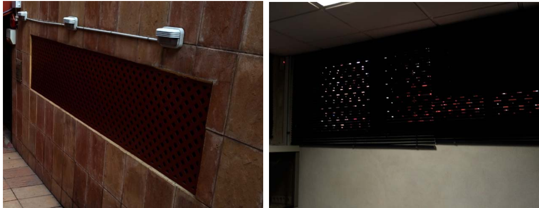
Imagen 3. Celosía metálica exterior - Carpintería aluminio sin RPT+ vidrio monolítico con dispositivo interior de control solar
